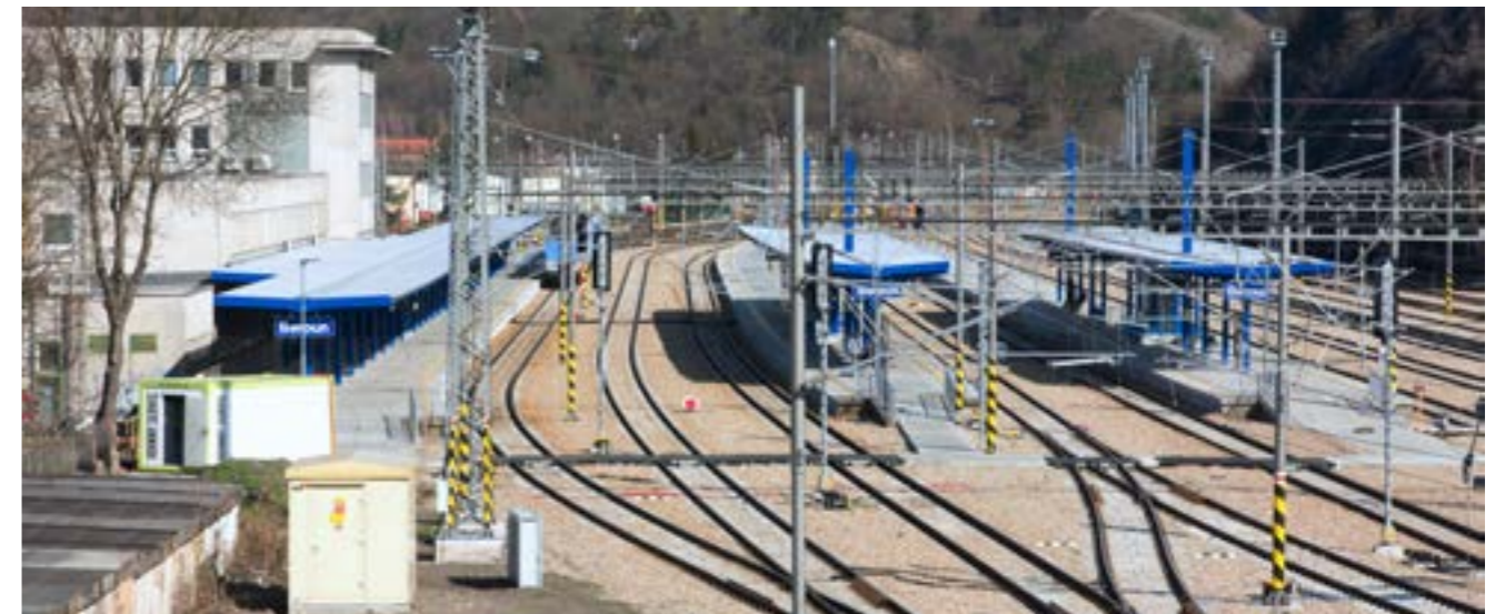
Celkový pohled na opravené kolejiště i nástupiště žst. Beroun.
