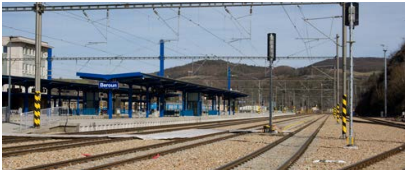
V rámci rekonstrukce žst. Beroun se opravilo i kolejiště osobního nádraží.
