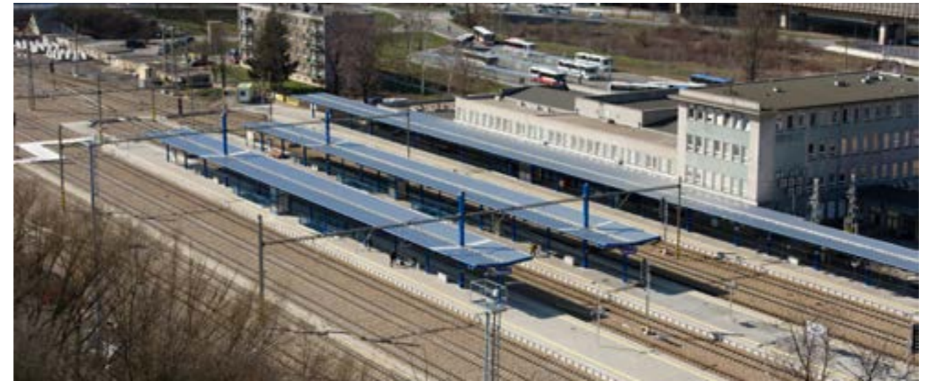
Téměř letecký pohled na žst. Beroun.
